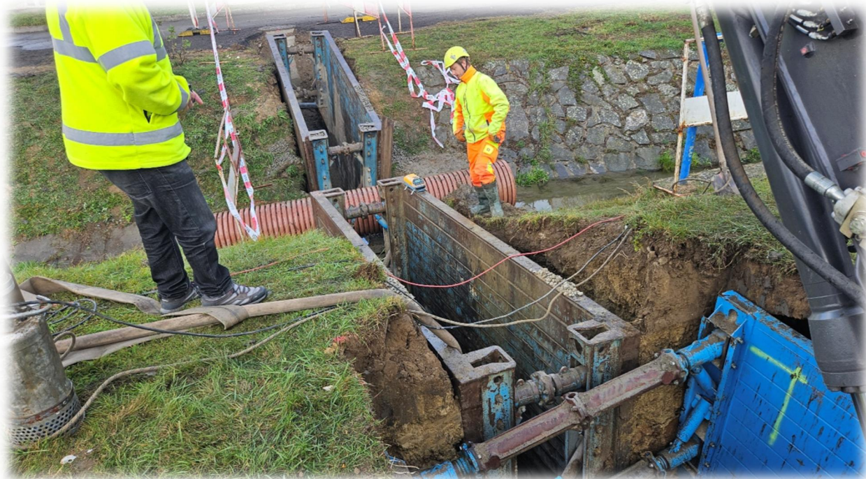
Nemochovice – stavba kanalizace
